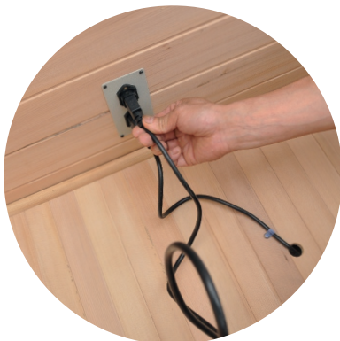
Zapojené kabely topidel
