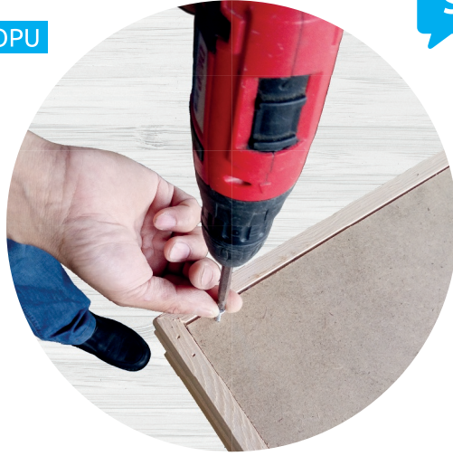
Umiestnenie krytu stropu
